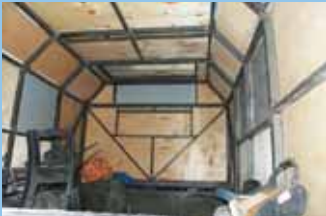
Работы по кузову только начались: впереди его утепление и внутренняя отделка, прорезка окон и, конечно, оборудование под автономное проживание
