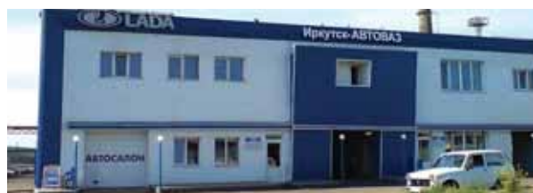
Иркутск-АвтоВАЗ внешне немного не соответствует классическим представлениям о современном дилерском центре. Однако здесь чисто, есть отдельный шоу-рум и, конечно, крупная сервисная станция, способная произвести любой ремонт автомобиля
